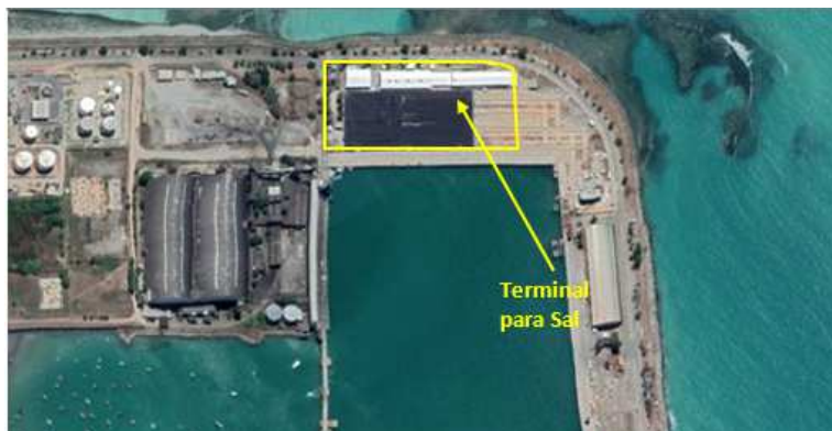
Figura 01: Área de Arrendamento MAC15 .
